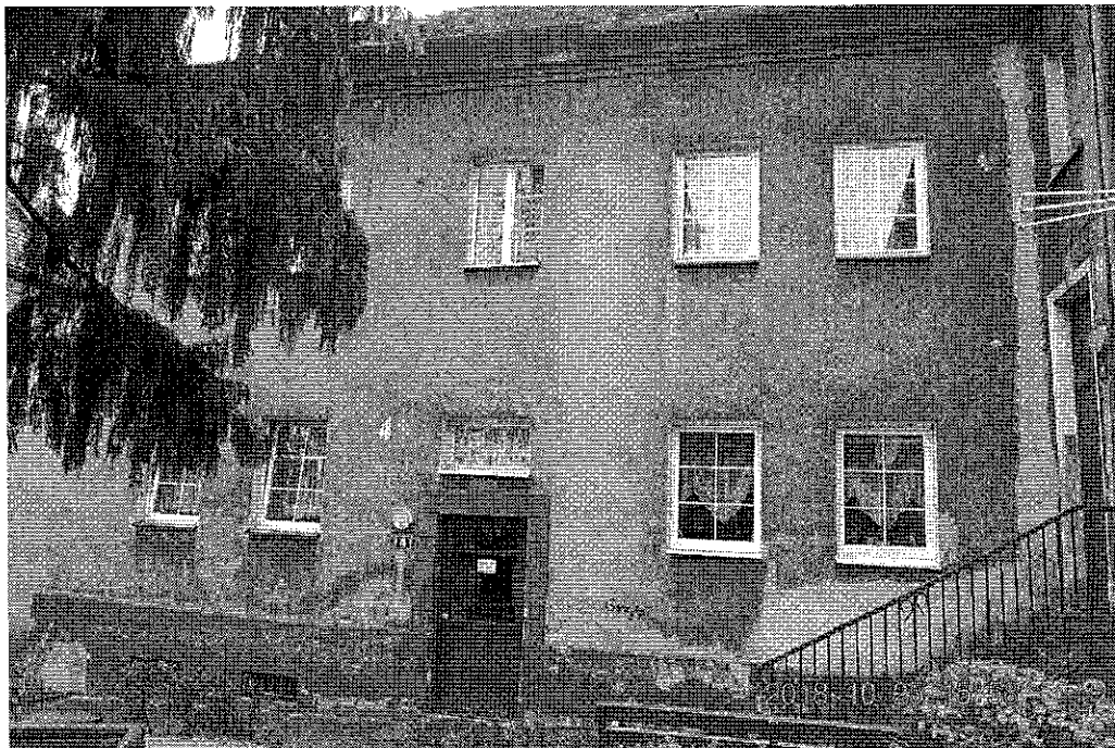
Elewacja od podwórza – wejście główne do budynku
